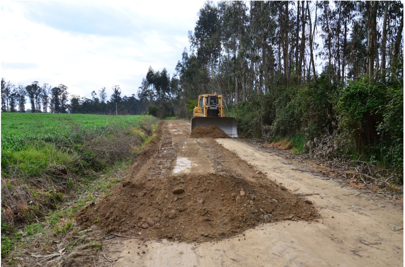
Estampa 3 – Momento dos trabalhos de arranjo do acesso.
