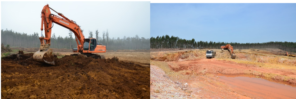
Estampa 18 – Pormenores do processo de escavação na área da plataforma
