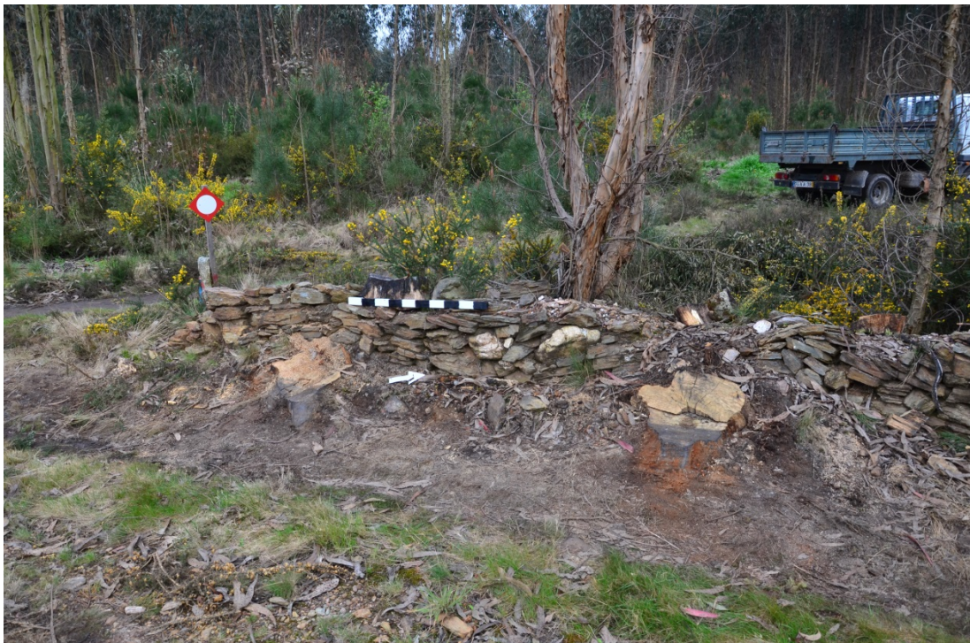
Estampa 4 – Registo fotográfico do muro nº2
