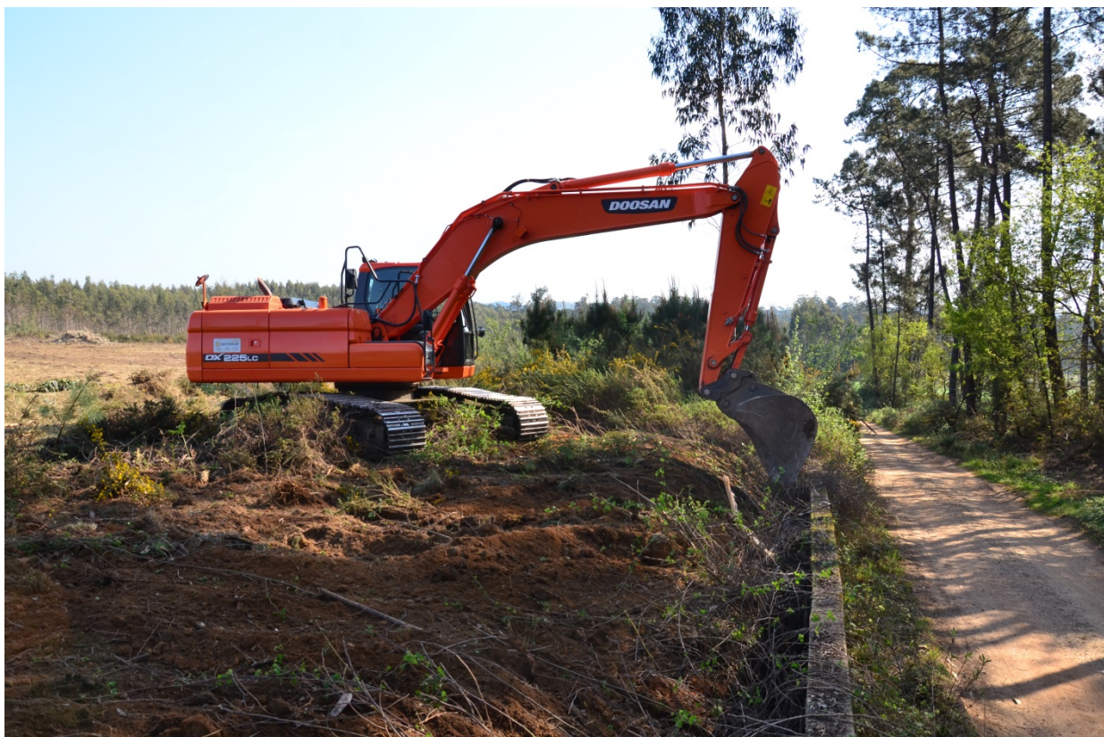
Estampa 2: Trabalhos de desmatção na área da entrada da plataforma
