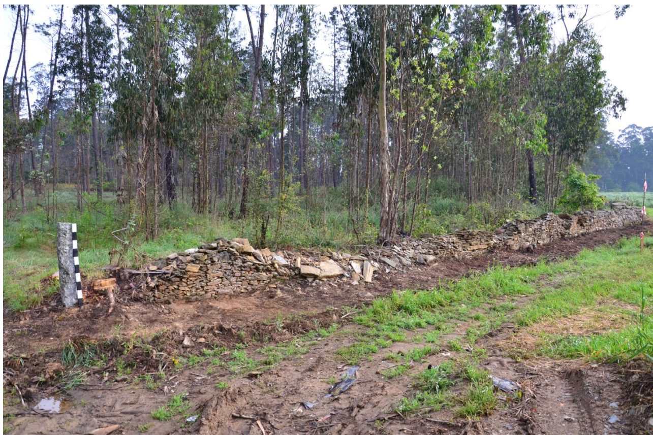
Estampa 16 – Registo fotográfico do muro nº9
