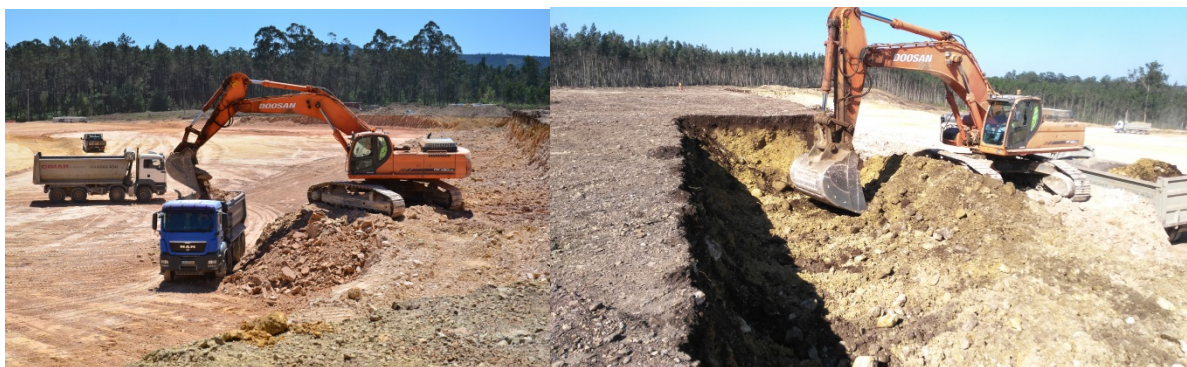
Estampa 23 – Trabalhos de escavação realizados no extremo NO da área de implantação da plataforma
