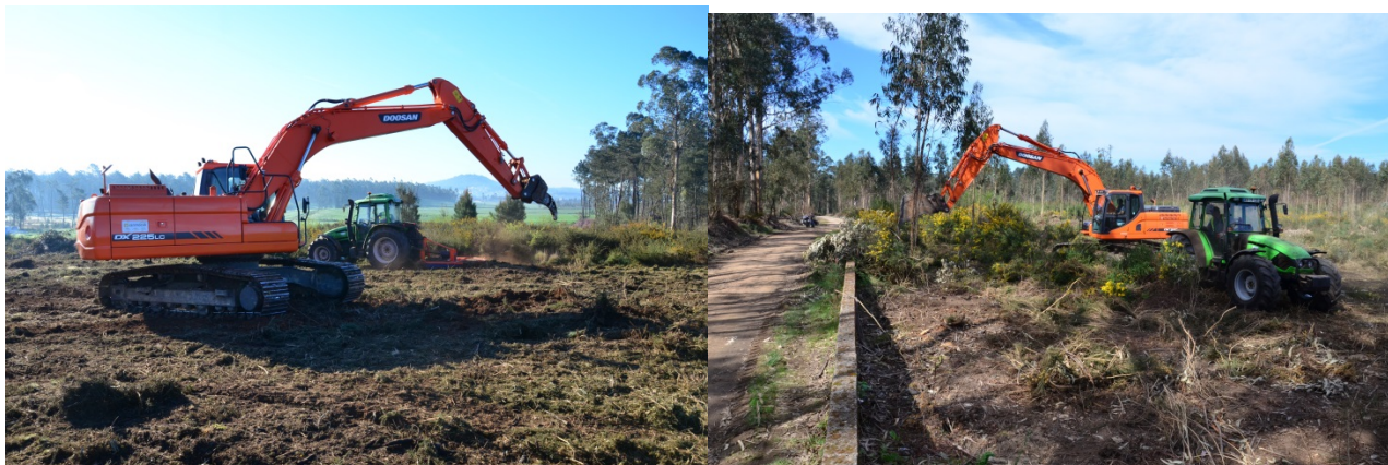
Estampa 1: Desmatção da área de implantação de estaleiro
