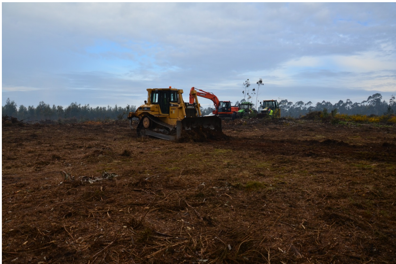
Estampa 8 – Registo dos trabalhos de decapagem
