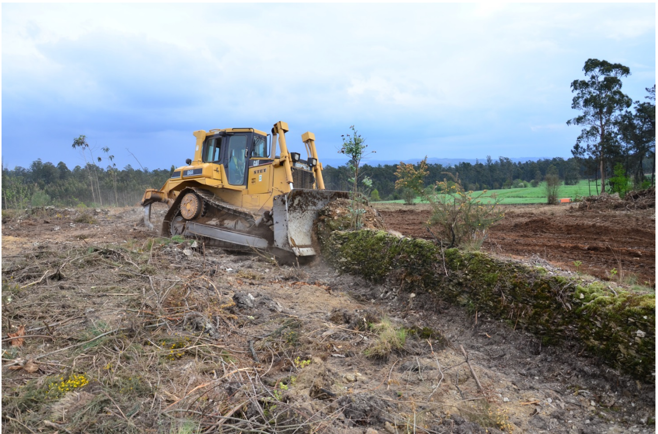
Estampa 11 – Momento de desmonte do muro nº4
