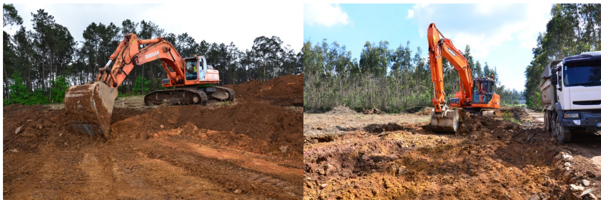
Estampa 15 – Registo dos trabalhos de escavação na área da plataforma e do acesso
