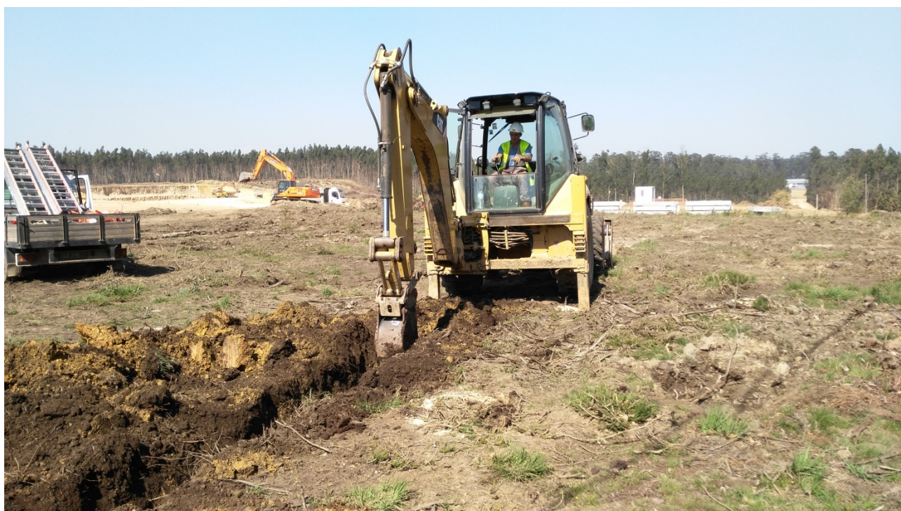
Estampa 20 – Trabalhos de abertura de valas nas imediações do estaleiro
