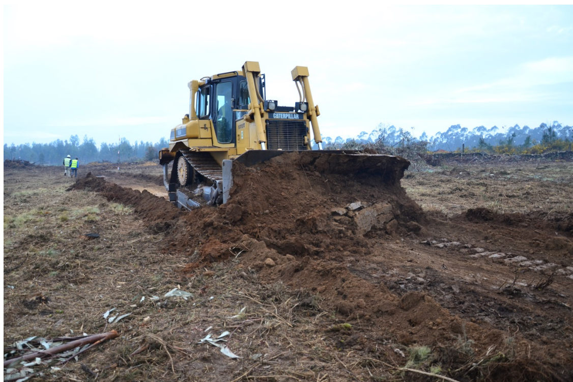
Estampa 9 – Momento dos trabalhos de decapagem da zona da plataforma
