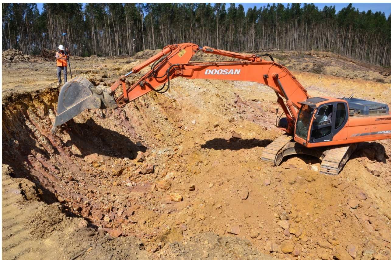
Estampa 19 – Momento dos trabalhos de escavação na zona NO da plataforma.
