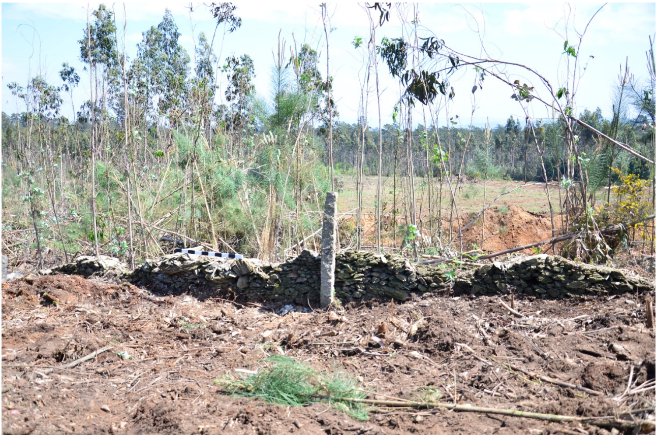
Estampa 13 – Registo fotográfico do muro nº 8
