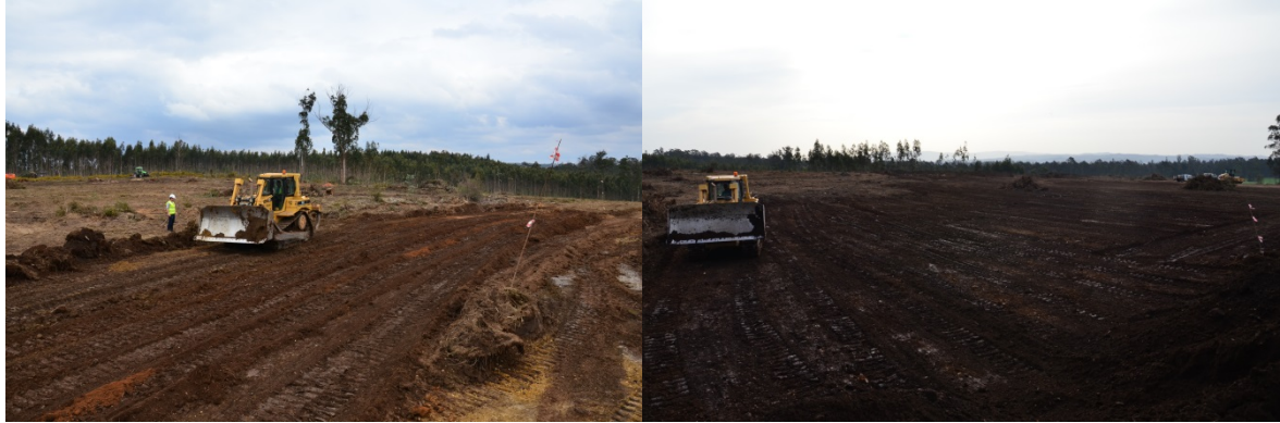
Estampa 10 – Pormenor dos trabalhos de decapagem da área da platadorma
