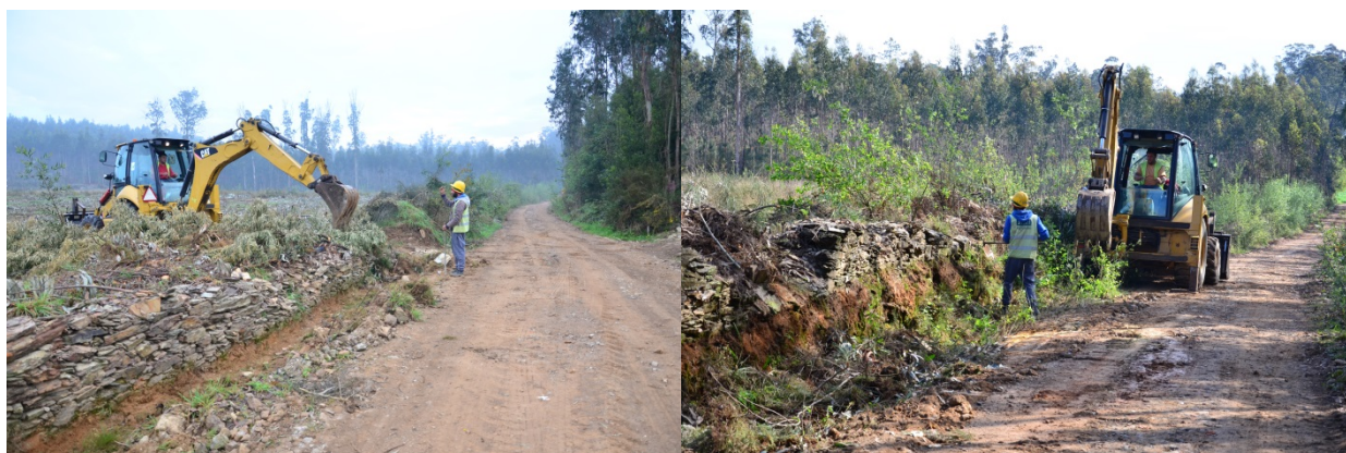
Estampa 6 – Trabalhos de limpeza do muro nº1
