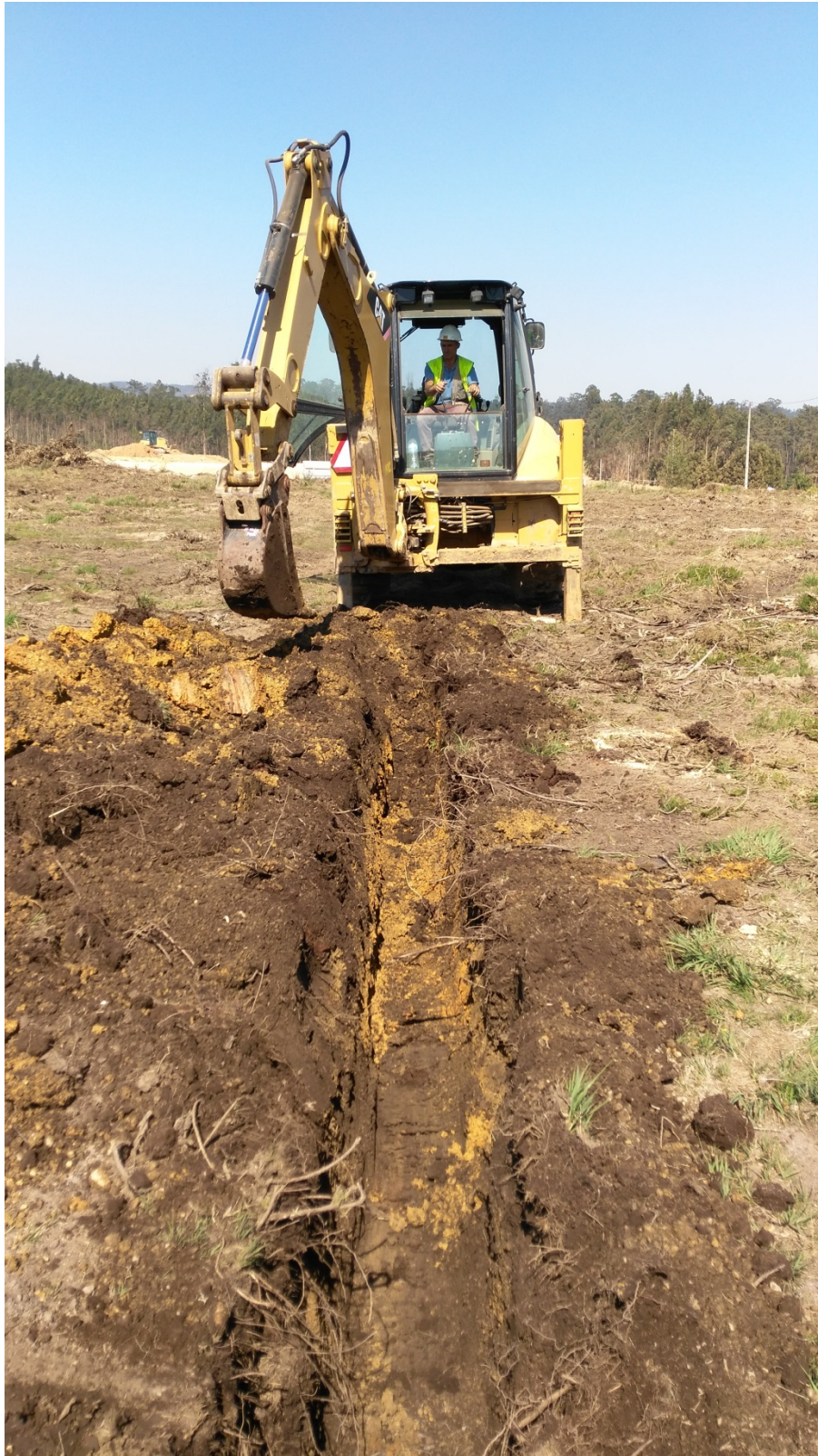
Estampa 7 – Vala aberta para a colocação de cabos de eletricidade
