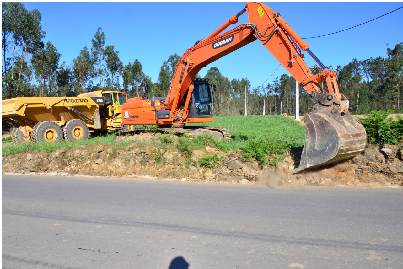
Estampa 22 – Trabalhos de decapagem realizados na parcela 5
