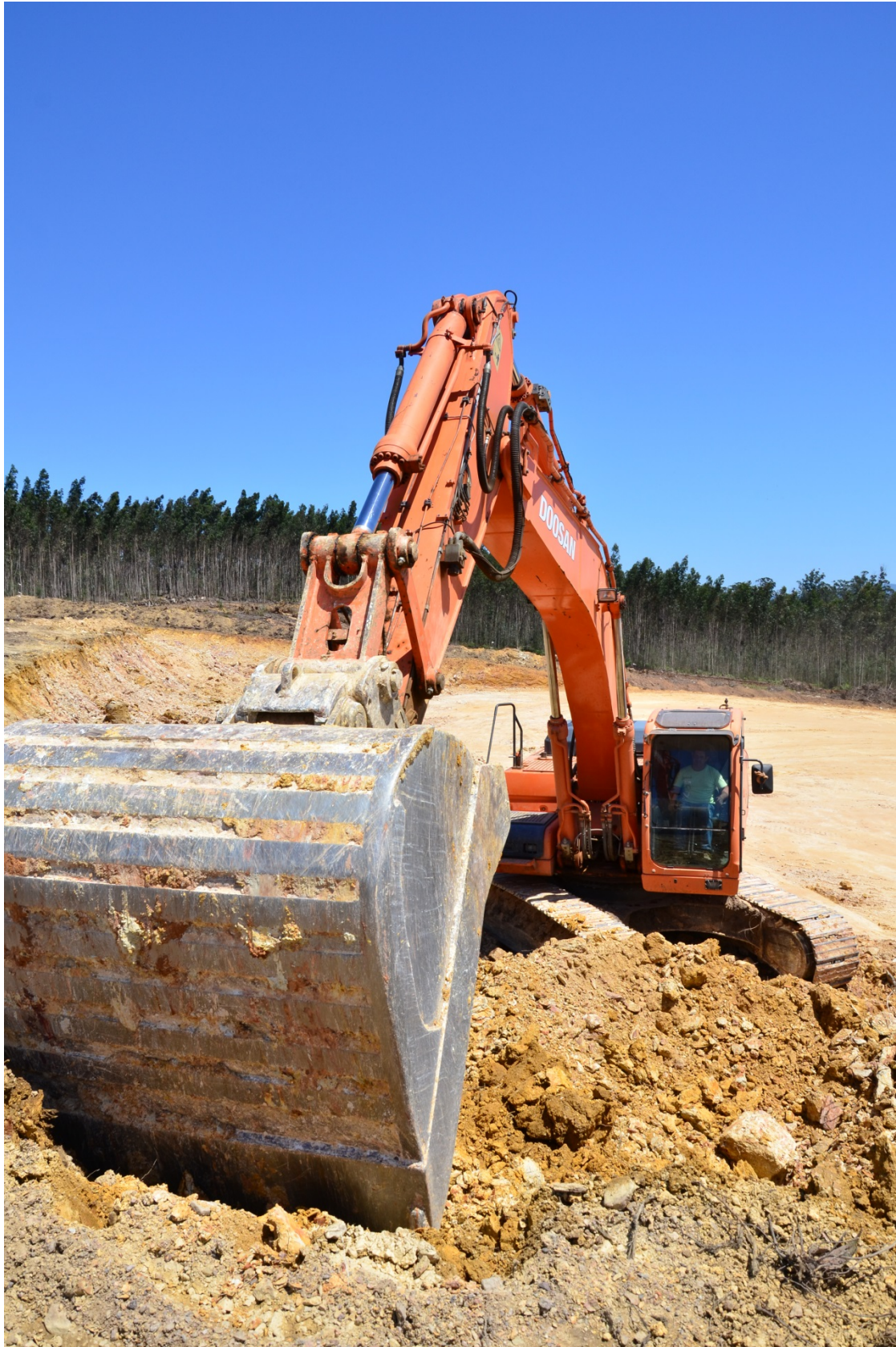
Estampa 21 – Momento dos trabalhos de escavação na zona NO da plataforma.
